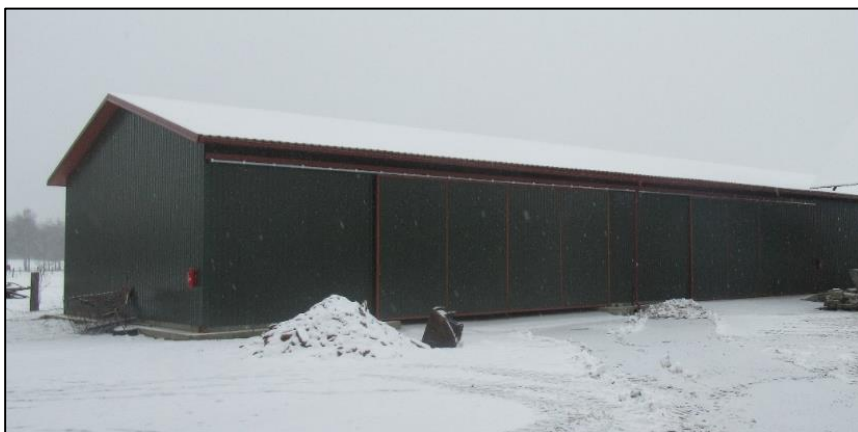
Obrázek 41: Výstavba skladu krmiv a rybářského vybavení (2. část)
