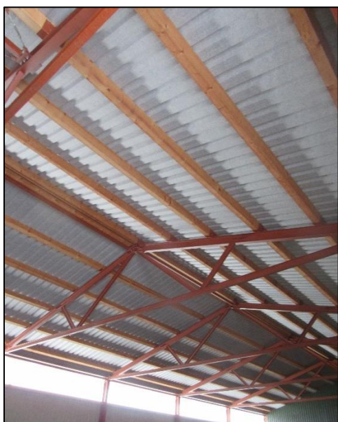
Obrázek 40: Výstavba skladu krmiv a rybářského vybavení (1. část)
