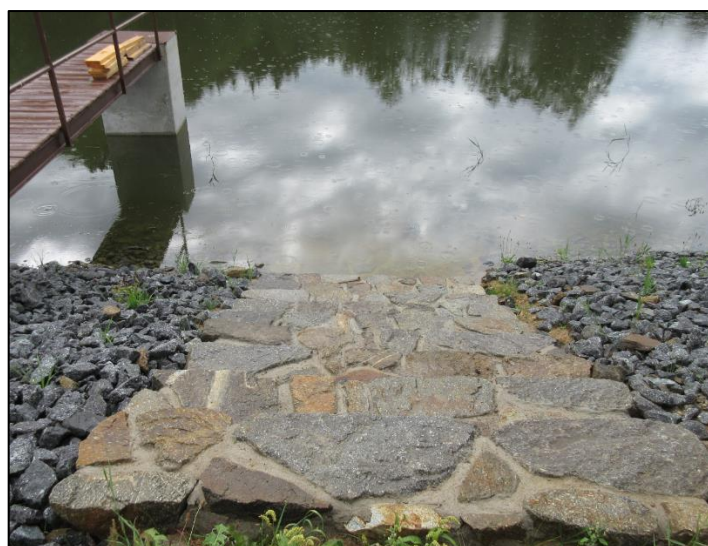
Obrázek 47: Oprava hráze (2. část)
