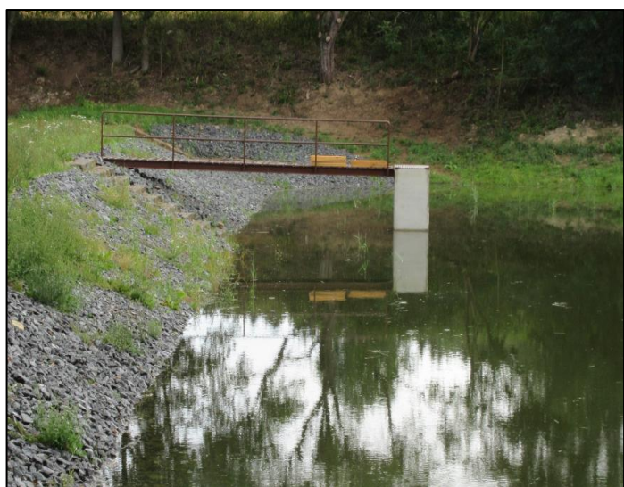
Obrázek 46: Oprava hráze (1. část)
