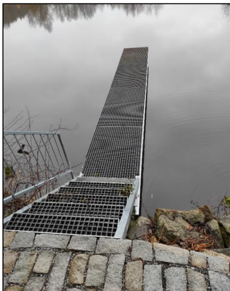
Obrázek 37: Vstup na lávku (1. část)
